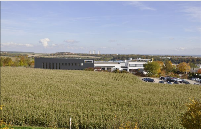
Zubler: Der Anbau des Firmengebäudes der Zubler beherbergt den Pausenraum, der neu gestaltet wird
